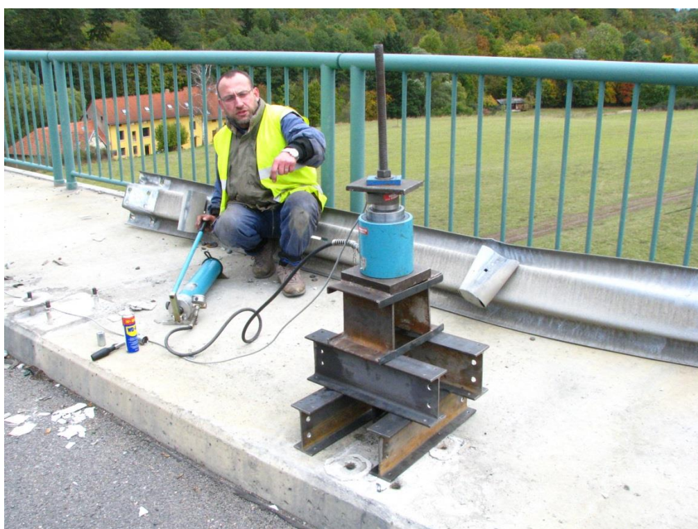
Obrázek 8.:Provádění osově zatěžovací zkoušky soudržné kotvy mostního svodidla odbornou osobou.
