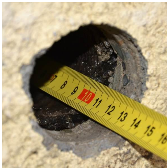
Obrázek 15.: V dutině sendvičového panelu ve vývrtu V 3 je patrná izolace Welit.
