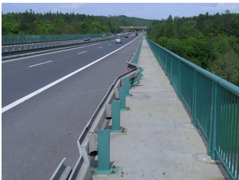
Obrázek 5.: Pohled na mostní konstrukci přes Voznický potok.
