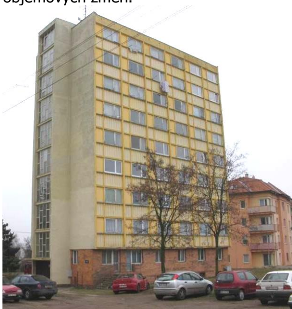
Obrázek 1.: Pohled na objekt (na severní hlavní fasádu).
