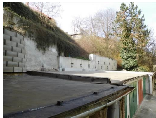
Obrázek 2.: Zajišťující kotvené opěrné stěny nad původními garážemi pod svahem. 05. 04. 2016.
