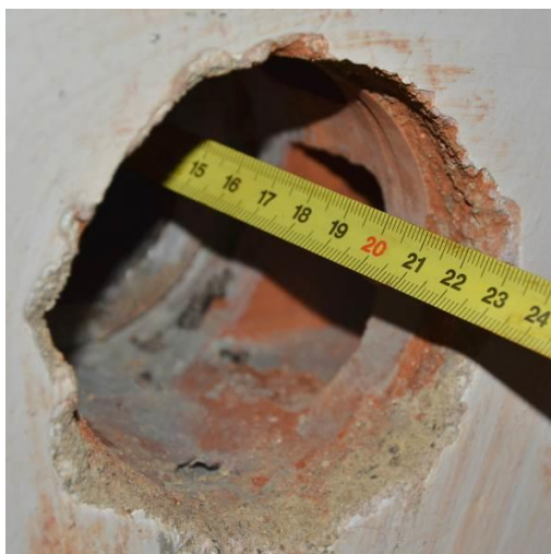
Obrázek 10.: Vývrt V 2 obvodového panelu. Zevnitř přizdívka z dutých cihel.
