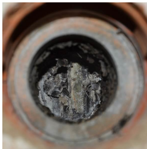
Obrázek 11.: Na konci vývrtu V 2 je v průhledu dobře patrná izolace Welit.
