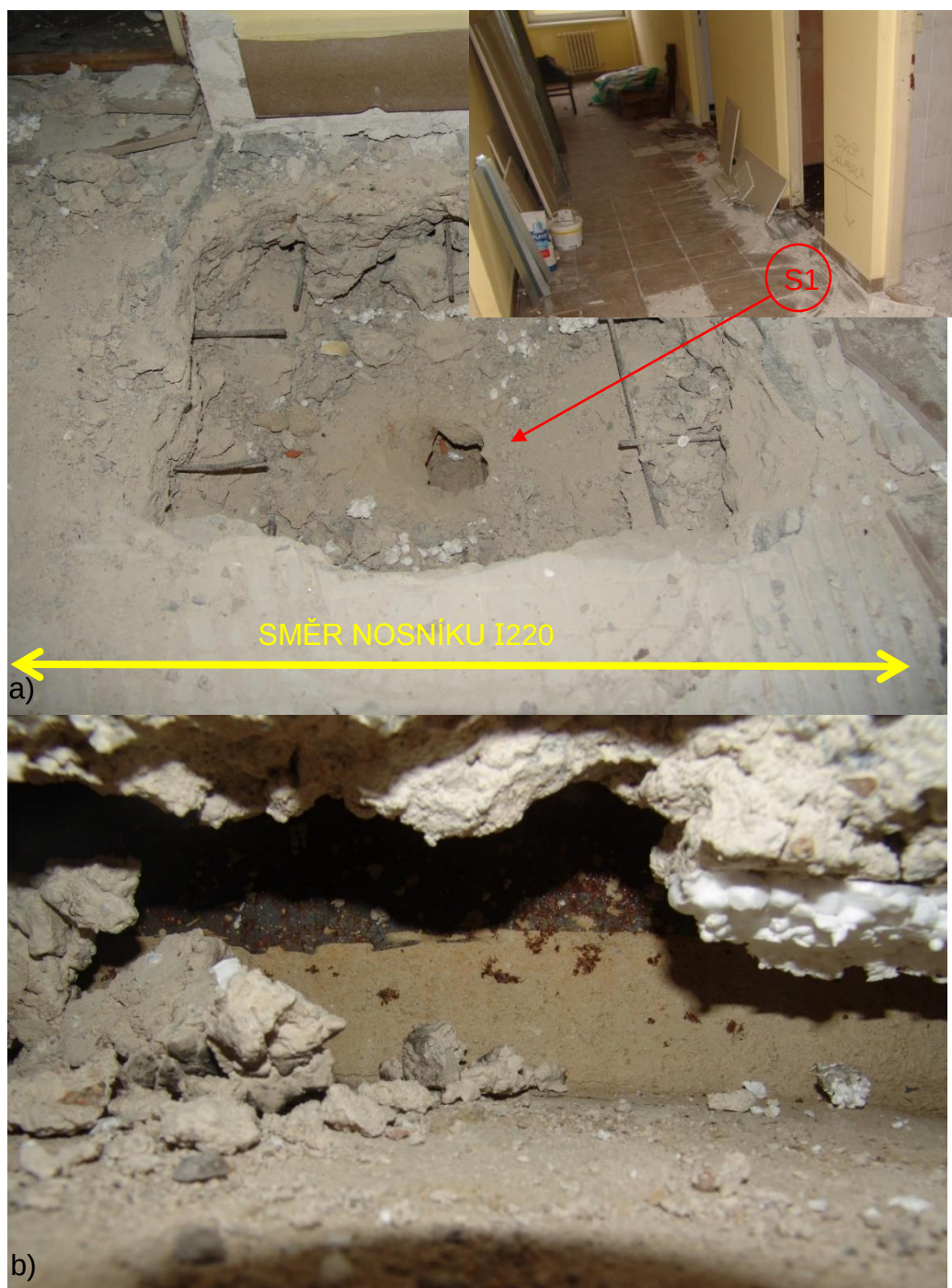
Obrázek 4.: Otevřená diagnostická sonda S1 podlahou v chodbě v 2.NP; a) pohled do otevřené sondy S1 včetně lokalizace na chodbě ve 2. NP (patrné soudržné souvrství vrchního cementového potěru a betonu, dále vzduchová kapsa s částečnými zbytky nevysublimovaného polystyrenu, pod kterou se nachází další vrstva cementového potěru a keramická stropní deska, beton je vyztužen kari sítí); b) souvrství stropní konstrukce spolu s ocelových I nosníkem
