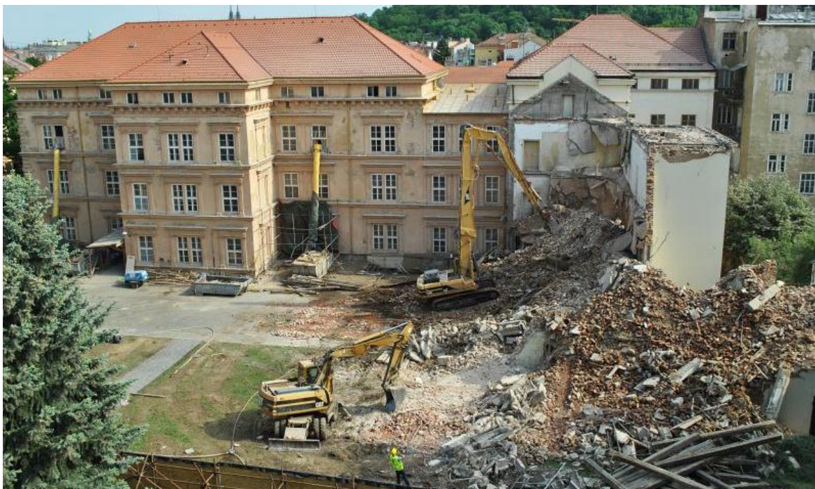
Obrázek 2.: Demolice přístavby objektu a probíhající rekonstrukce původní budovy - původ posuzovaného souboru cihel (foto encyklopedie.brna.cz)
