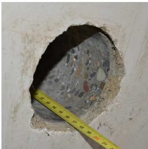
Obrázek 6: Vývrt V 1 do nosného sloupu.
