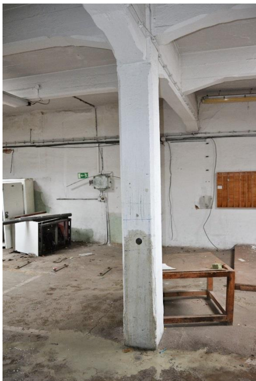
Obrázek 2.: Část nosné konstrukce staré tovární budovy, ze sloupu odebrán vývrt o průměru 50 mm.
