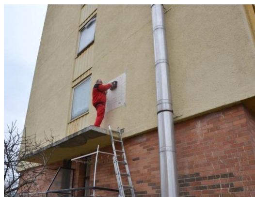
Obrázek 5.: Místo odběru vývrty V 3 v obvodovém štítovém panelu na jižní straně domu. Před odběrem bylo provedeno měření radarem.
