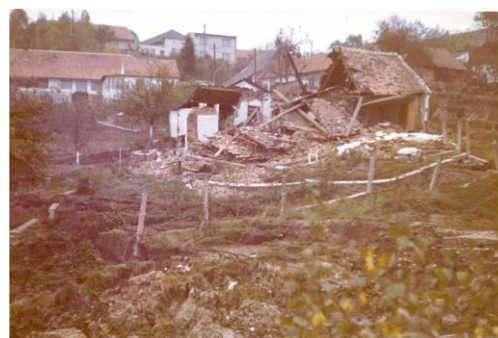
Obr. 10.: Celková devastace domu – výsledek svahového pohybu.
